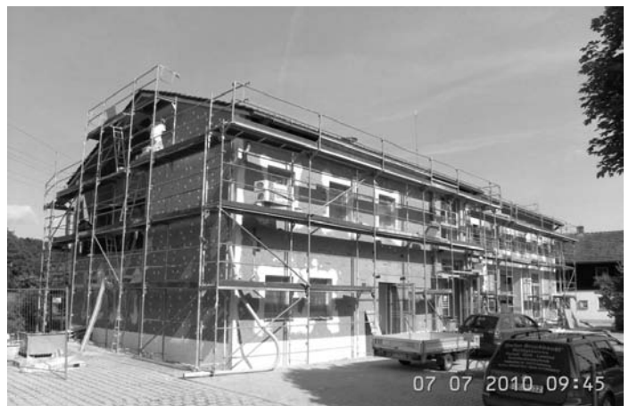
Zeigt Blick auf die Baumaßnahme.
