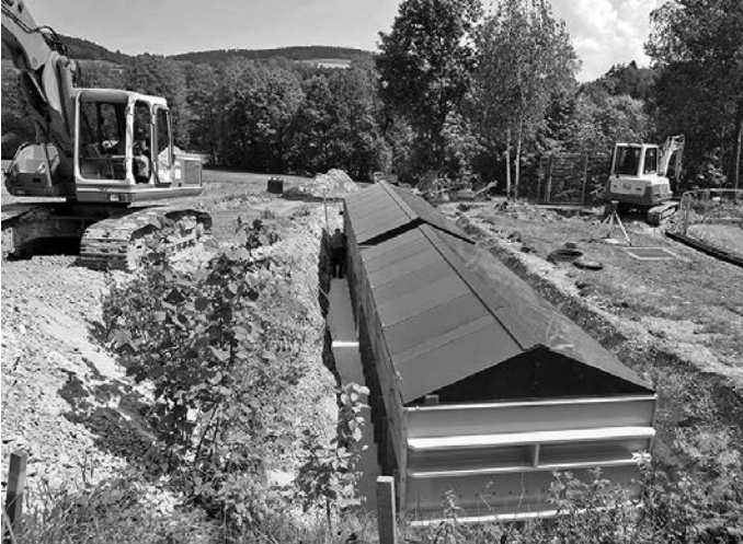
Es geht zügig voran in der Kläranlage Wetzelsberg
